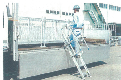
▲側面あおりを倒して設置
